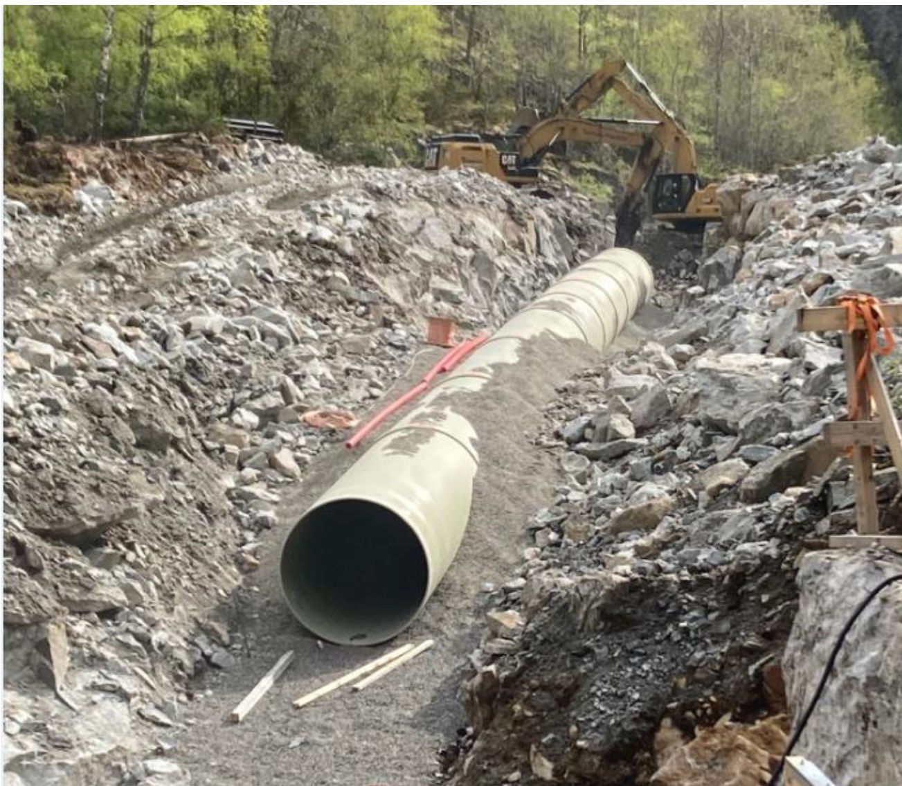
Legging av ny røyrgate til nye Tveitafoss Kraftverk
